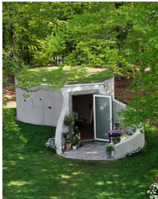
Fasadepussen er hvitpigmentert for å lyse opp betongens naturlige farge..
