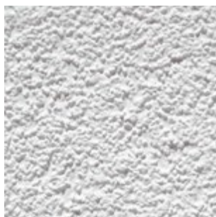
Fasadepuss 2,0 mm Silikat eller silikonharts med skurt overflate. Kan også utføres som stenkpusset overflatebehandling.
