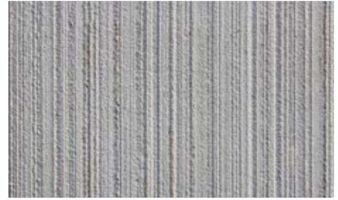
Alle Finjas kantelementer med betong har børstet overflate.
